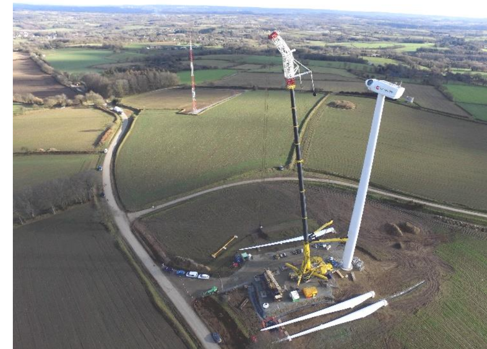
Figure 49: Vue aérienne d'une plateforme de montage
