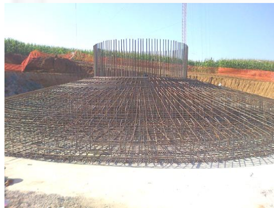
Mise en place de l'armature métallique
