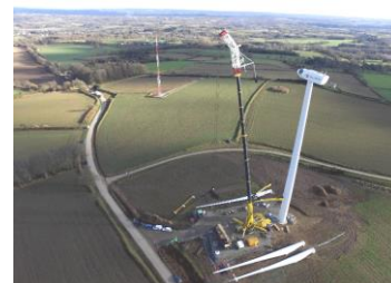
Figure 7 : Vue aérienne d'une plateforme de montage
