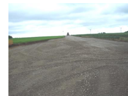
Chemin de chantier
