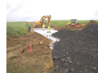
Pose d'un géotextile
